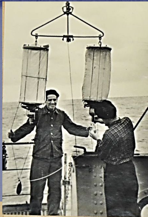
Планктонособиратель конструкции Богорова. Сливание улова из стаканчика.
